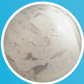
PRIMA DELLA RIMOZIONE
